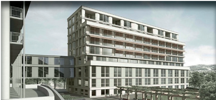
Neubau Wohn- und Bürozentrum für Körperbehinderte (WBZ) WBZ Liegenschaften AG, Reinach 2018-2021
